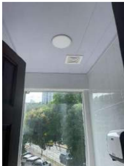
Instalación del baño en el anexo del decanato
