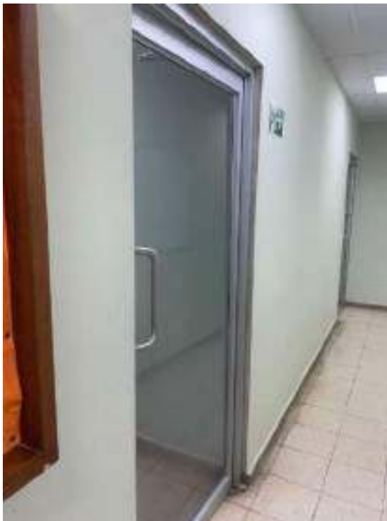
Instalación de puertas de vidrio en el anexo del decanato
