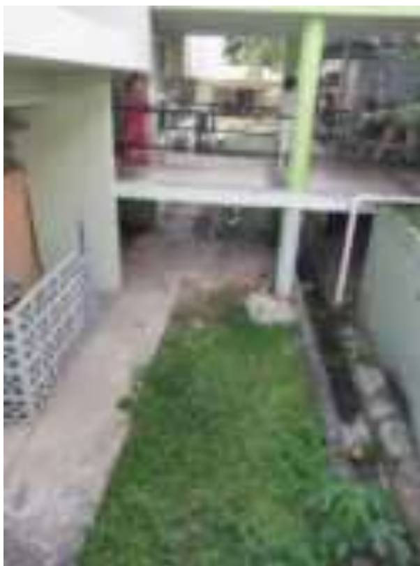
Descarte de las sillas que se encontraban debajo del pasillo que conecta con Microbiología.
